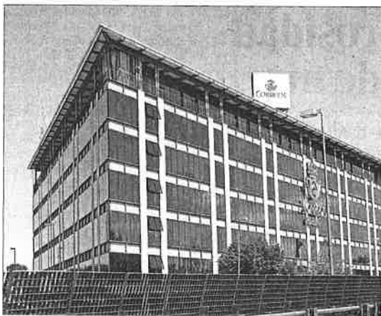
Edificio de la nueva central de Correos de Madrid, en agosto. / E. N. (EFE)
