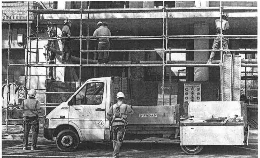
Varlos obreros trabajan en la obra de un edificio de viviendas de nueva construcción en Zaragoza. EFE
