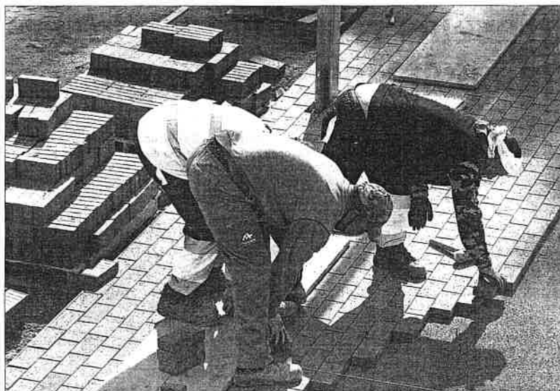
Trabajadores de la construcción en el puerto de Mataró. / CRISTÓBAL CASTRO
